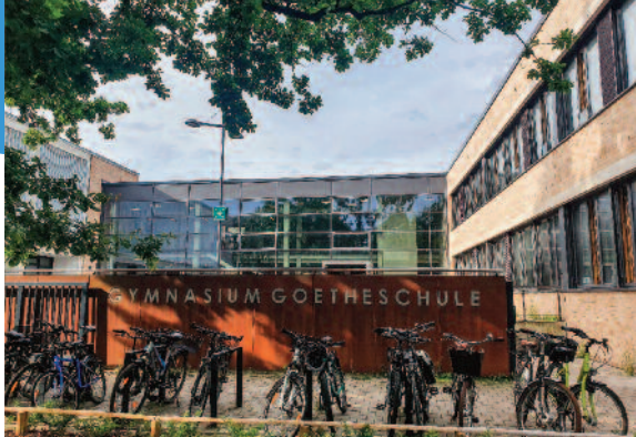
Die Goetheschule nach dem Umbau
